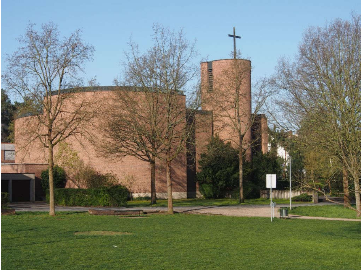
Blick auf die Nordseite der Kirche
